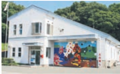
完成したシャッターの壁画
