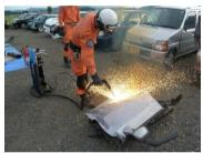
酸素溶断器は、従来のガス切断器と異なり、アルミニウム、真ちゅう、ステンレスなどの各種金属や、スラブを素早く溶解切断することができる万能型の切断装置です。
